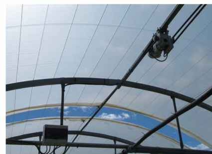
Hrebeňové odvetrávanie s fóliovým posuvom
